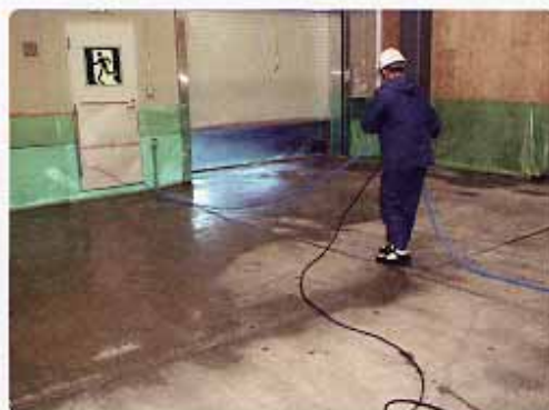
北海道にある漁業協同組合水産物加工作業所の床面。クラック拡大抑制と改質を目的としてナノコンシーラを全面塗布。
