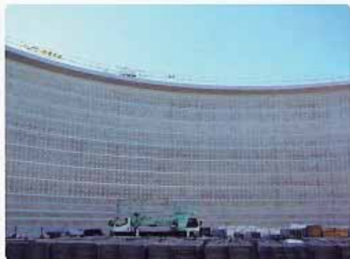
尾之鼻ファームボンドは規模としては鹿児島県内有数のファームボンド。クラック抑制を目的として、ファームボンドの内壁全面にナノコンシーラを塗布。
