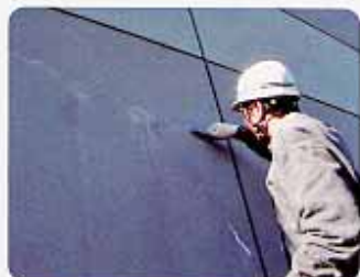
1. 外壁面の白華(エフロ)除去
