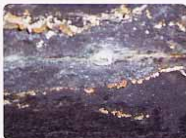
北海道にある漁業協同組合水産物加工作業所の床面。クラック拡大抑制と改質を目的としてナノコンシーラを全面塗布。
