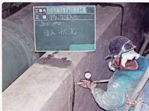
発電所の取水構造物の修繕工事。耐震安全性向上のために微小クラック内部にナノコンシーラを注入。
