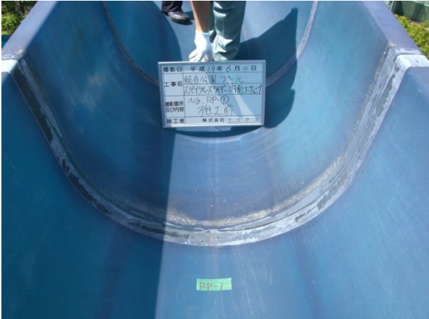
【施工目的】某社FRP製プール滑り台施設の表面保護コーティング施工
