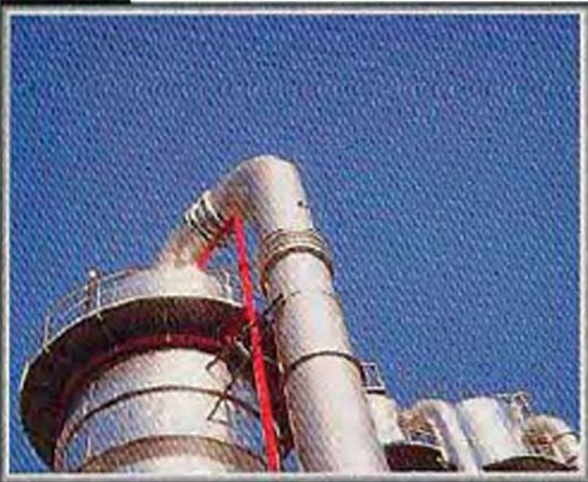
プラント 化学薬品・潮風・熱・ガス
