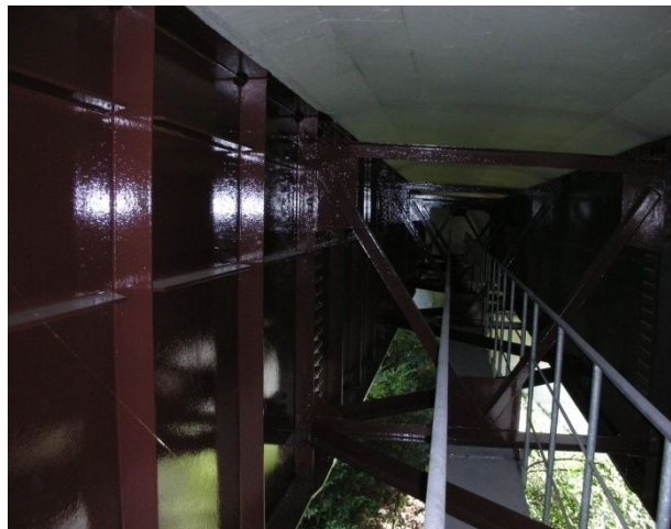
【施工目的】高速道路の橋梁鉄部の保護コーティング施工
