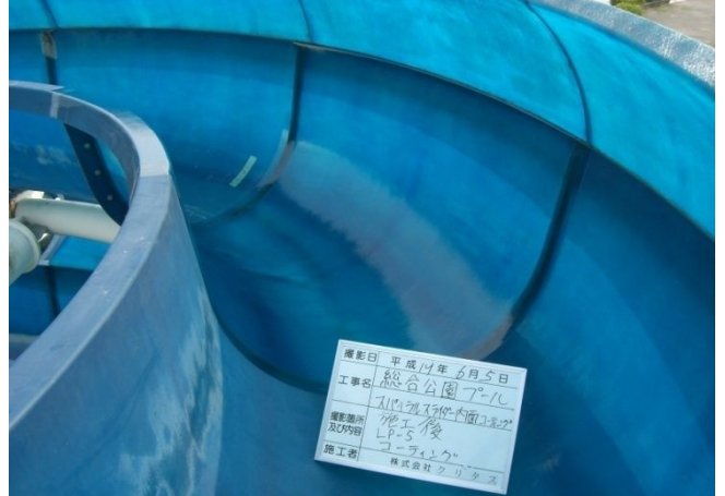
【施工目的】某社FRP製プール滑り台施設の表面保護コーティング施工
